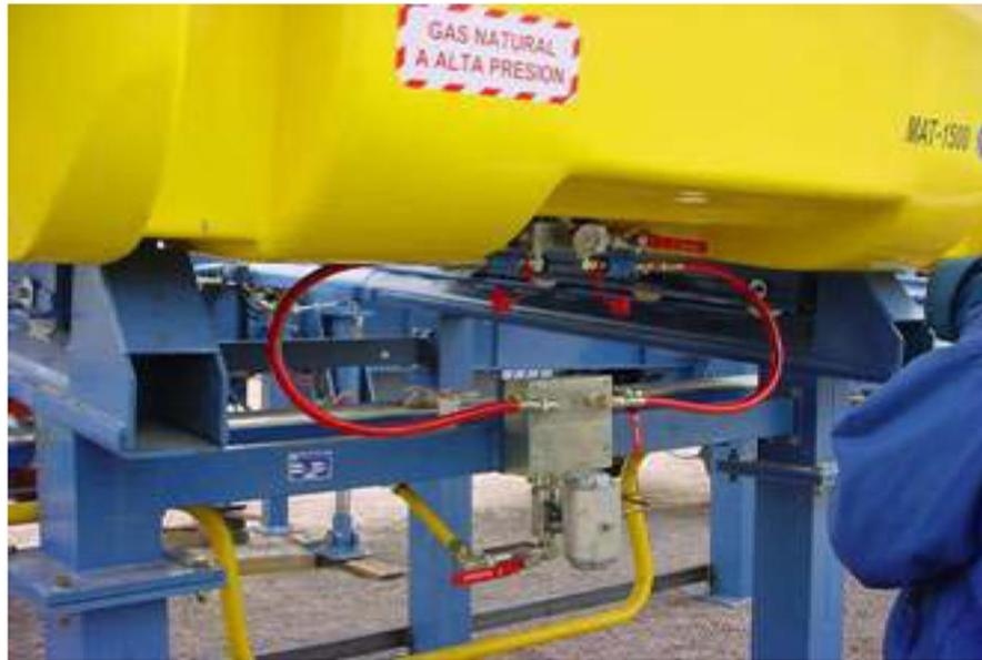
**Figura N° 11: Dispositivo de seguridad en el transporte de gas natural**
