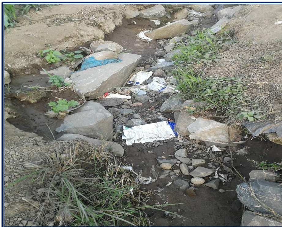
Figura 58. Visita a campo presencia de residuos en canales de irrigación.
