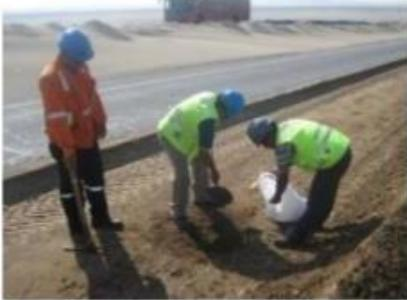
MUESTREO PARA PODER ENSAYAR Y VERIFICAR LA CALIDAD DE LOS MATERIALES EN CAMPO SEGÚN FRECUENCIA DE ENSAYOS.
