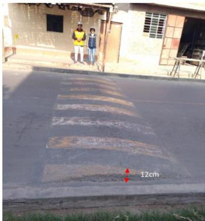
Figura 10: Reductor de velocidad poco visibles
