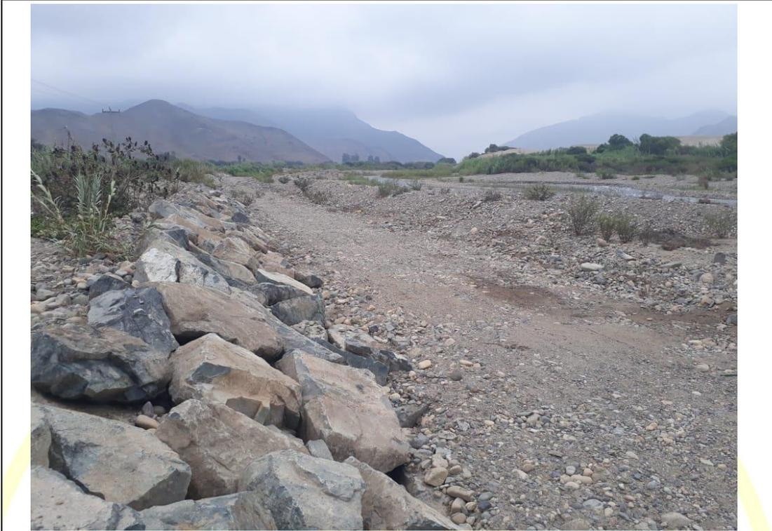
**Fotografía 09:** Vista aguas arriba del río, en Acceso a Centro Arqueológico Caral, cuenta con protección enrocado el cual falló en periodo de lluvias 2017
