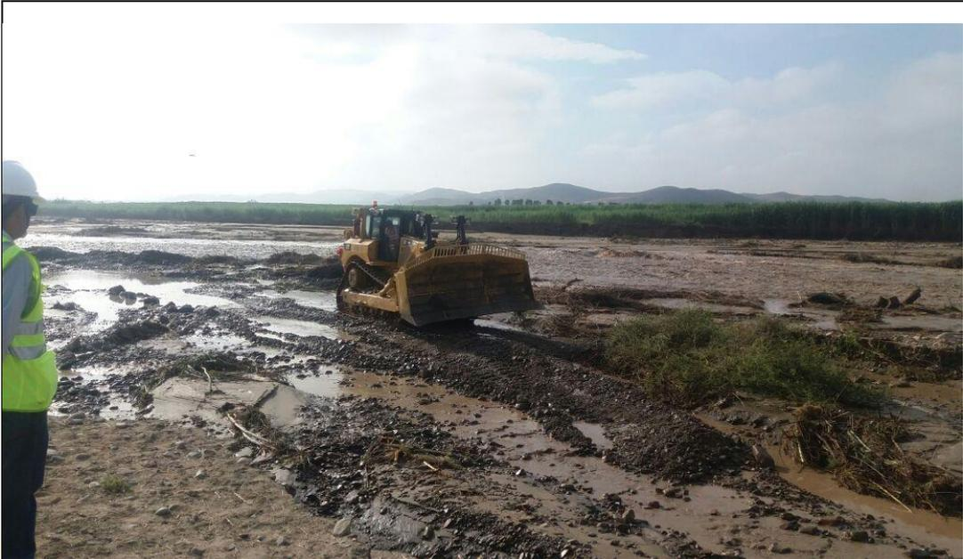
**Fotografía 01:** Trabajos de limpieza y descolmatación del río Supe, para encauzamiento del río en el periodo de lluvias 2017.
