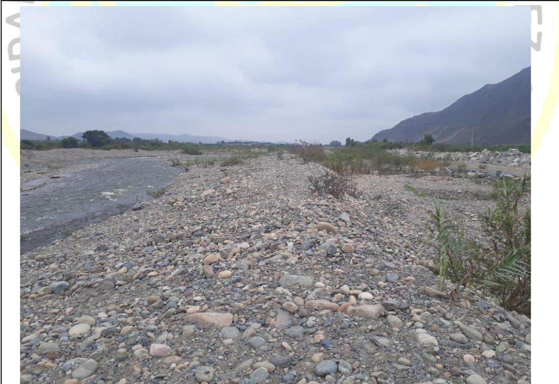
**Fotografía 10:** Vista aguas abajo del río, en Acceso a Centro Arqueológico Caral, cuenta con protección enrocado el cual falló en periodo de lluvias 2017
