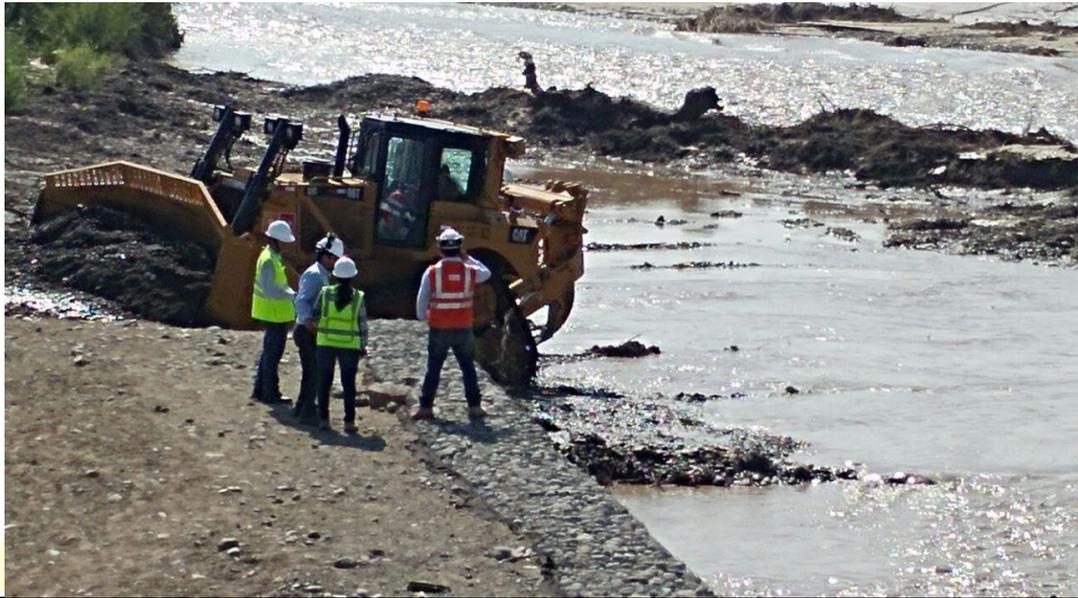
**Fotografía 03:** Primeros trabajos de acopio de conglomerado con material del río descolmatado.
