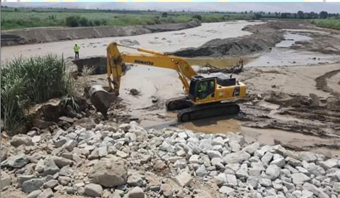
**Fotografía 02:** Trabajos de protección con enrocado al Puente Supe y Carretera Panamericana Norte debido al desborde del río Supe.
