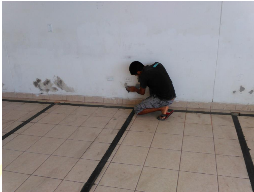
Foto N° 3. Realizando resane en las paredes de las aulas.
