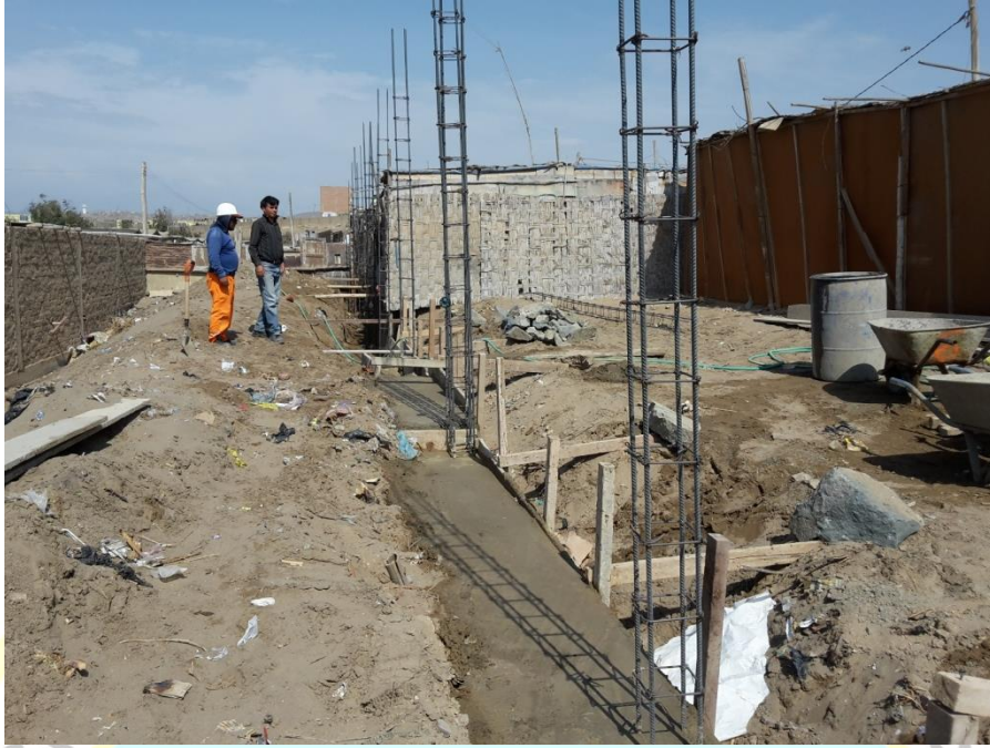
Foto N° 15. Encofrado y vaciado de cemento corrido del cerco perimétrico adicional
