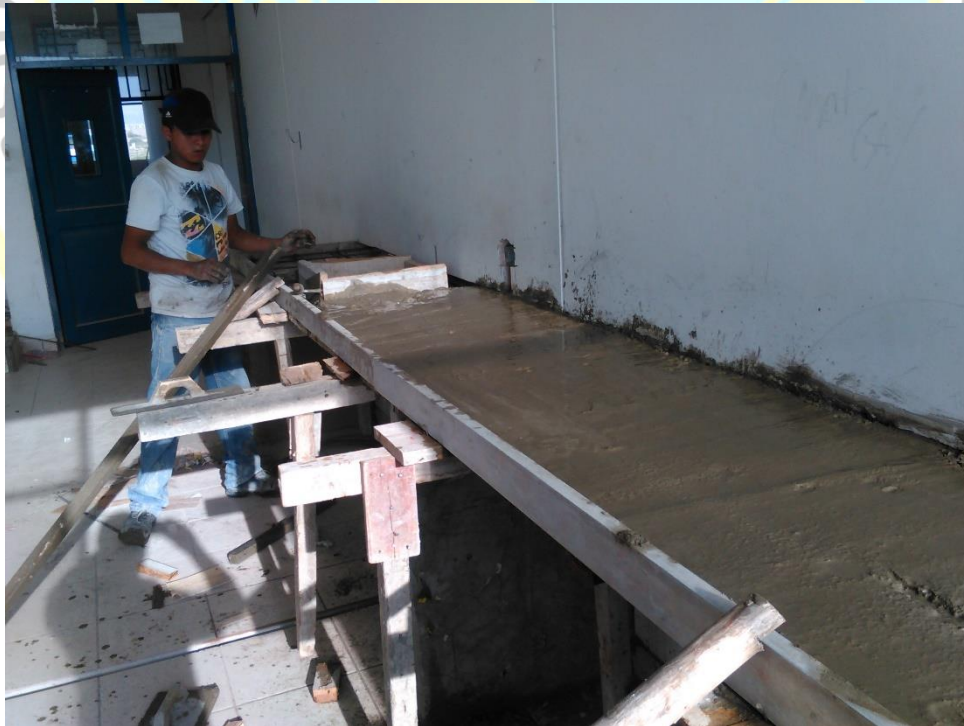
Foto N° 6. Vaciado de cemento
