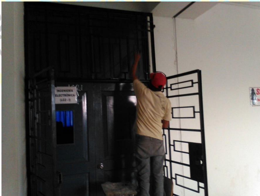
Foto N° 2. Arreglando las puertas metálicas
