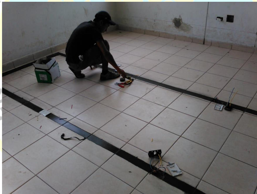
Foto N° 4. Realizando acabados finales con cemento en las líneas de electricidad en el laboratorio de computo.
