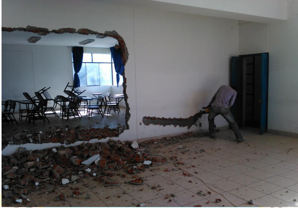
Foto N° 7. Ampliación de aula de computo y resane de pared.
