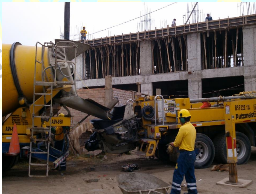
Foto N° 8. Vaciado de concreto premezclado para el techo encofrado del 2do. Piso
