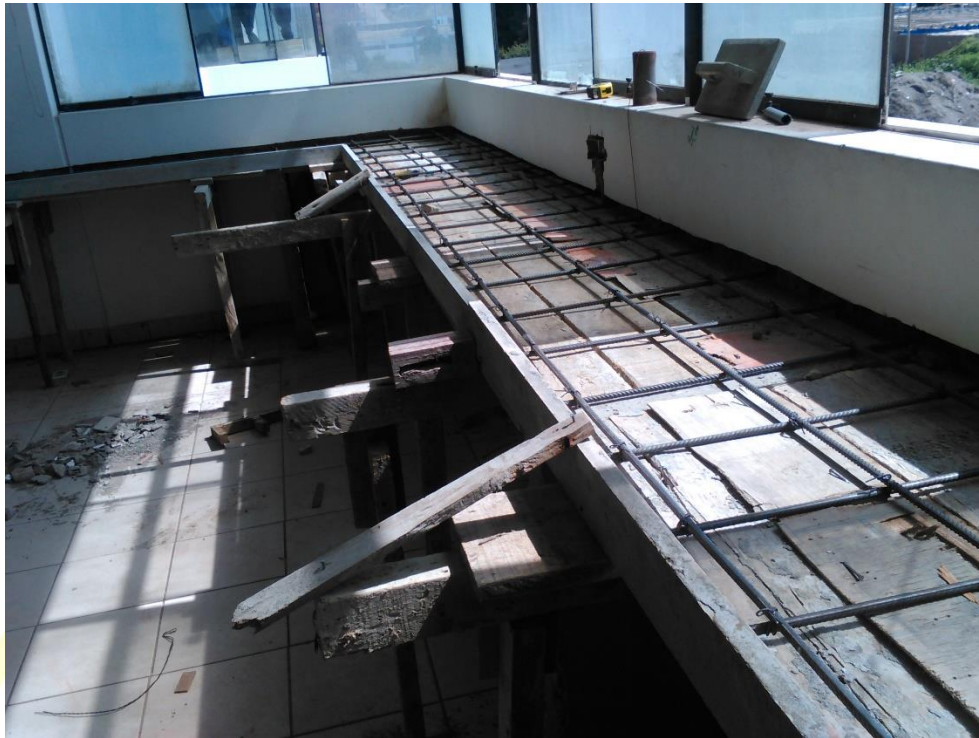
Foto N°5. Armandando la estructura de fierro para los voladizos laterales de cemento encofrado
