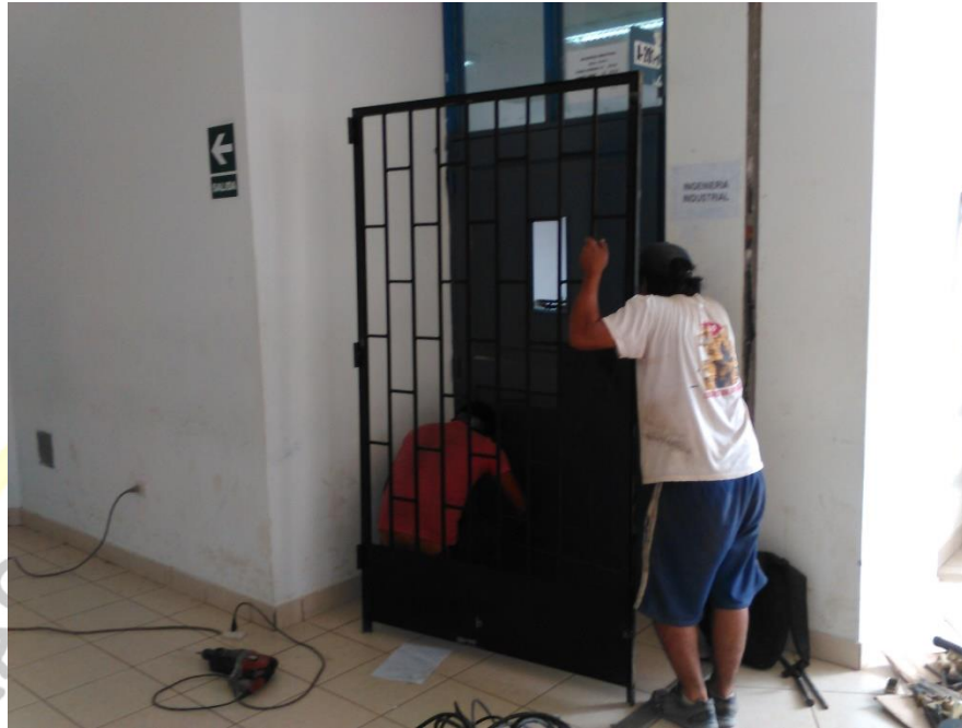
Foto N° 1. Soldando las puertas metálicas para dotar de seguridad a los laboratorios
