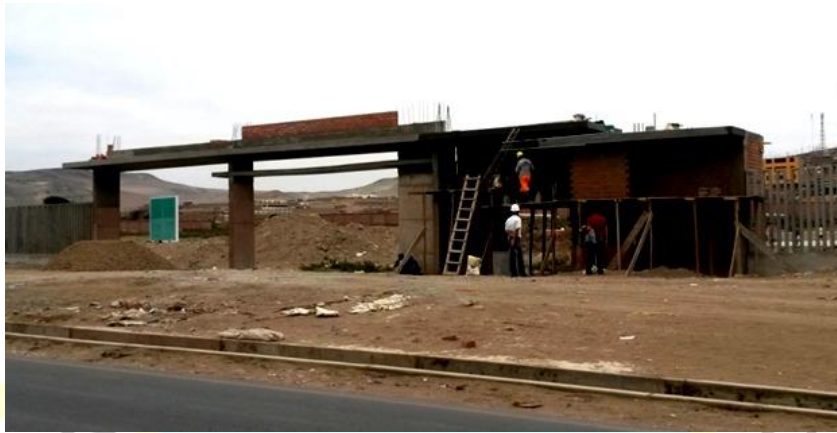
Foto N° 13. Vista fotográfica del tarrajeo de ingreso y tarrajeo de caseta de vigilancia
