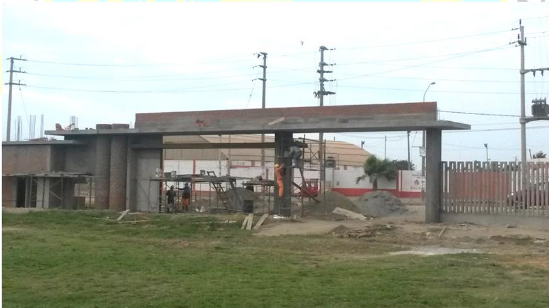
Foto N° 12. Vista fotográfica del ingreso N° 05 proyectado en proceso de tarrajeo
