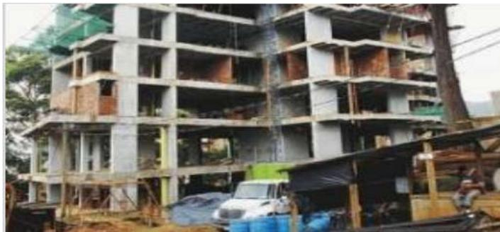
**Figura 19:** Sistema estructural Dual
