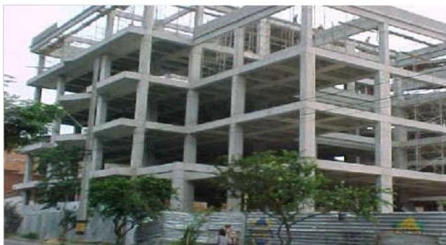
**Figura 17:** Sistema estructural Tipo Pórtico
