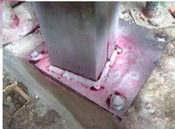
Presencia de porosidad agrupada en la junta J1, presencia de fusión incompleta en la junta J6, ambas son rechazada de acuerdo a los criterios de aceptación de inspección visual – Tabla 6.1 AWS D1.1/D1.1M: 2015.
