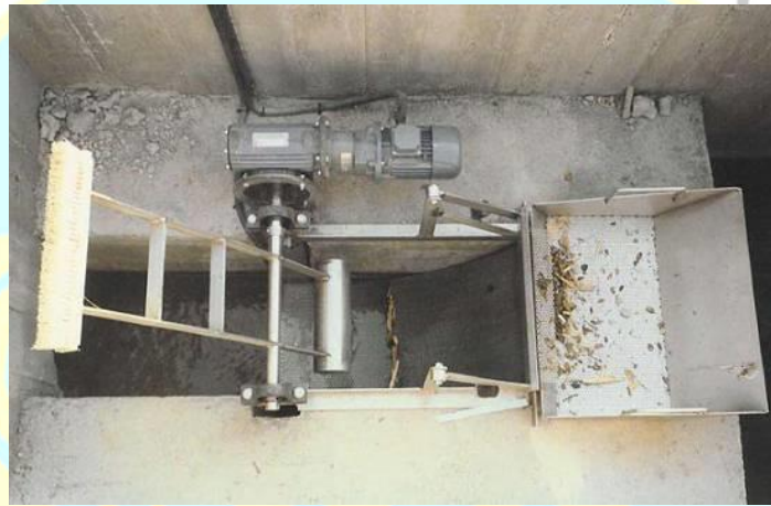
Ilustración 13: Rejilla de limpieza mecánica con peine giratorio. Imagen tomada de: http://www.interempresas.net/Química/FeriaVirtual/Producto-Reja-de-desbaste-37170.html
