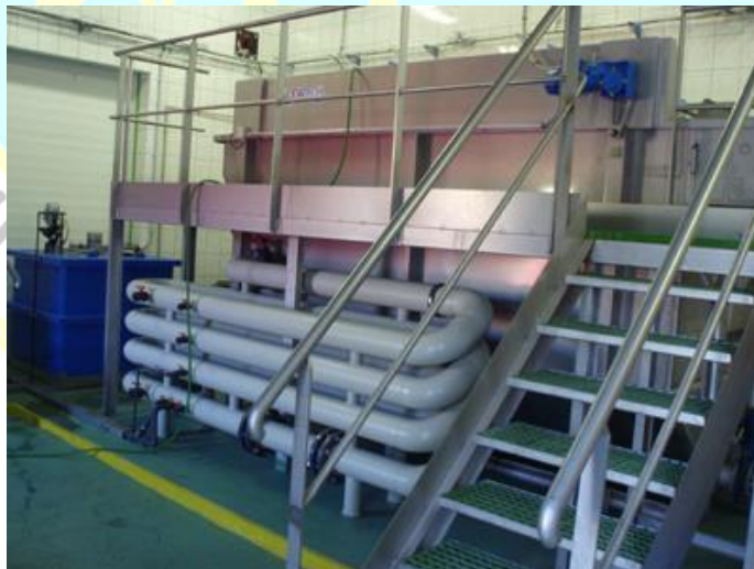
Ilustración 27: Tratamiento primario químicamente asistido. En primer plano, el serpentín de mezcla. Imagen tomada de: http://prechistvatelni-valgeo.com/wp-content/uploads/2011/02/DAF12.jpg
