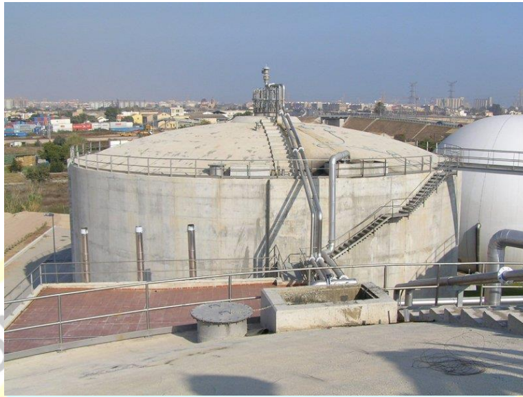
Ilustración 55: Digestor Anaerobio con conducciones de biogás y recirculación de fangos digeridos. Imagen tomada de: http://usuarios.arsystel.com/raulh/edar_pinedo/1246.jpg
