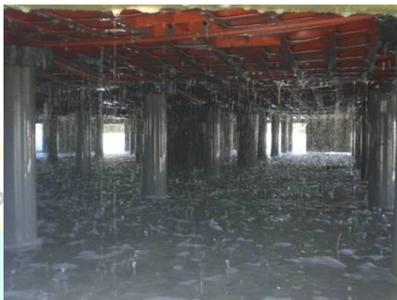
Ilustración 49: Base de un filtro percolador con aberturas de ventilación. En la parte superior se aprecia el falso fondo como sistema de drenaje. Imagen tomada de: http://www.egevasa.es/portal/export/sites/default/Tecnologia/ImagenesTecnicasEgevasa/FiltroPercolador1.jpg_729600497.jpg
