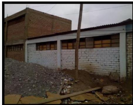
Se observa el deterioro de las columnas por los efectos de los sulfatos y en la fotografía 33, observa la condición deteriorada de las coberturas de calamina las cual siempre representa riesgos latentes a los alumnos.
