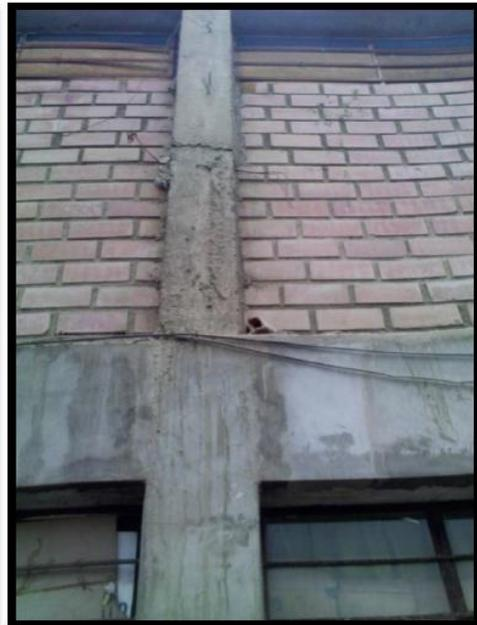
Se pone en evidencia que las construcciones se realizaron sin la supervisión de ningún profesional Ingeniero o Arquitecto, se observa también que los bloques no cuentan con junta sísmica, además en el bloque de lado se puede
