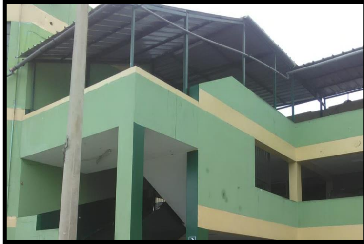
Figura N° 58: Estructura metálica en el tercer piso.
