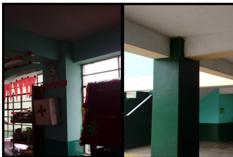
Figura N° 63: Bloque C – Conexión Viga Columna
