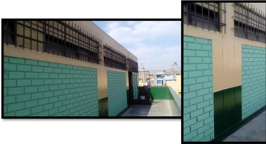
Figura N° 52: Bloque B – Vistas del Segundo Piso
