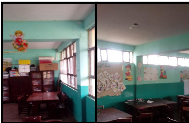
Figura N° 40: Bloque A – Conexión Viga Columna
