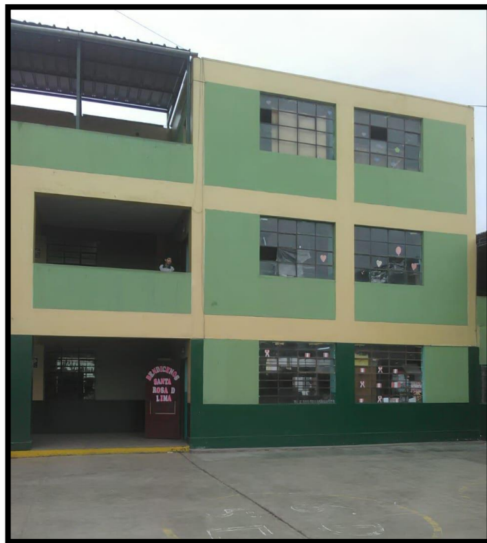
Figura N° 62: Bloque C – Vista lateral.
