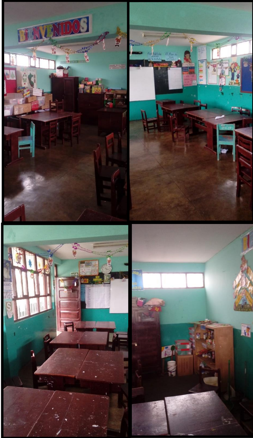
Figura N° 43: Bloque A – Vista Interior de aulas
