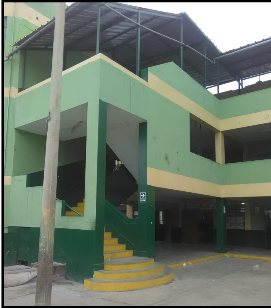
Figura N° 56: Vista Frontal del Bloque C
