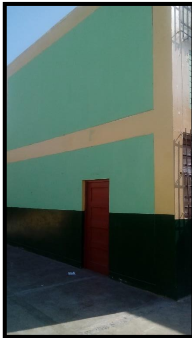
Figura N° 53: Bloque B – Vista lateral
