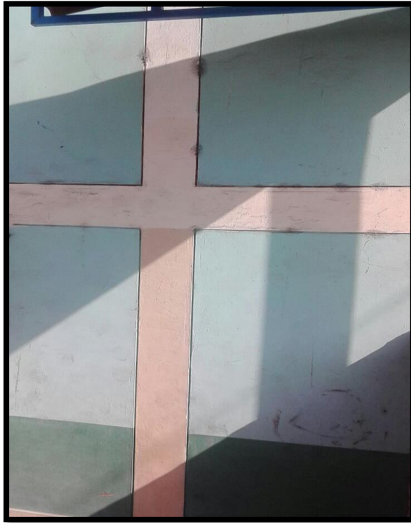
Figura N° 57: Bloque "C" Vista lateral.
