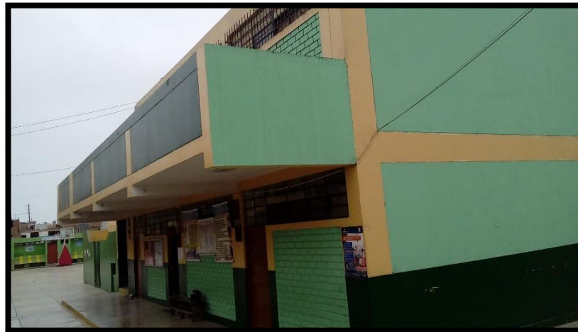
Figura N° 51: Bloque B – Confinamiento en tabiquería
