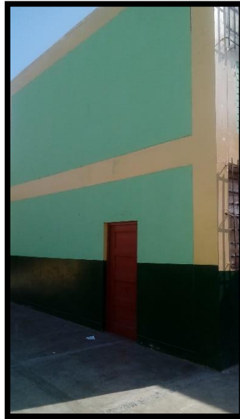
Figura N° 54: Bloque B – Confinamiento de muros
