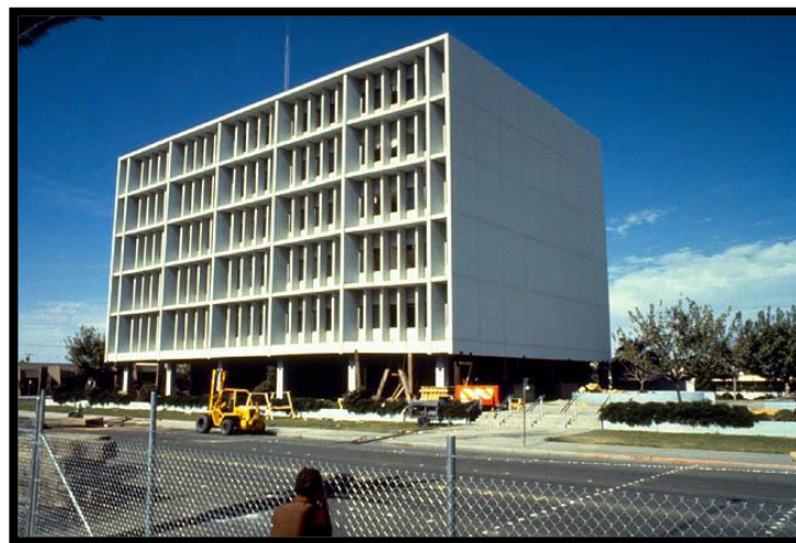
Figura N° 10: Piso blando en el primer piso Fuente: Internet
