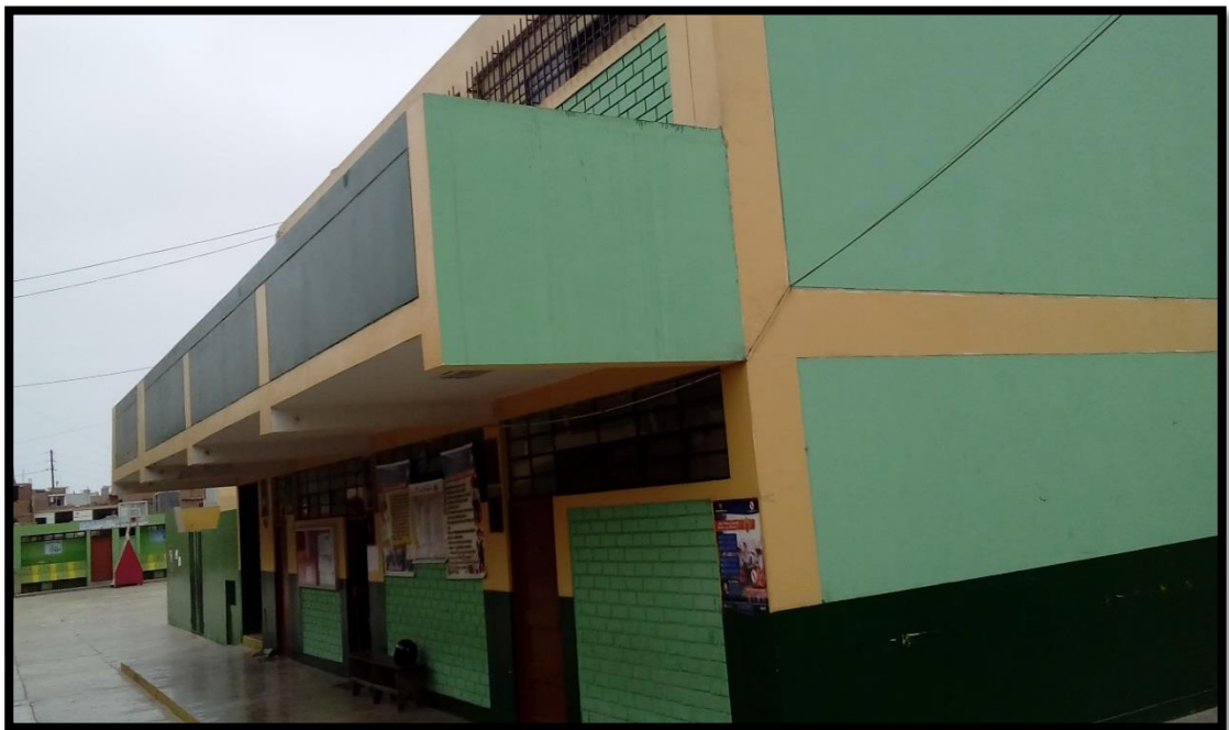
Figura N° 47: Vista Frontal del bloque B
