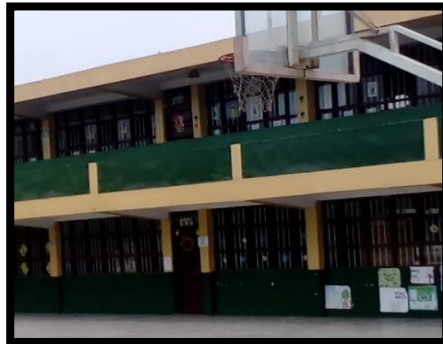
Figura N° 38: Bloque A - Ventanas que abarcan más del 60% del paño de un muro
