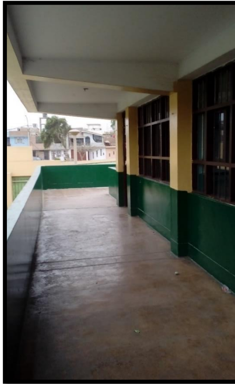
Figura N° 44 : Bloque A – Voladizo
