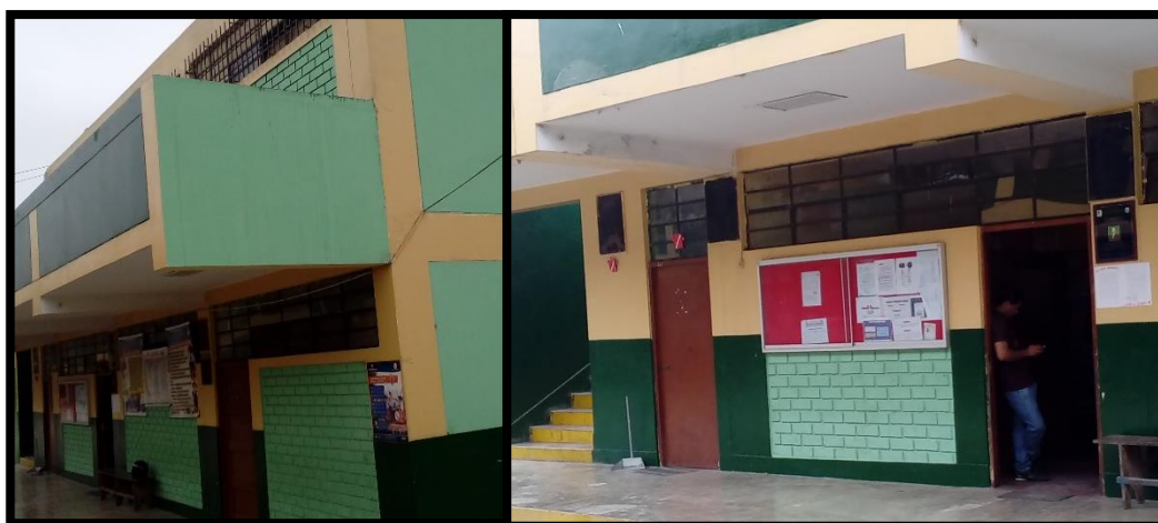
Figura N° 49: Bloque B – Conexión Viga Columna
