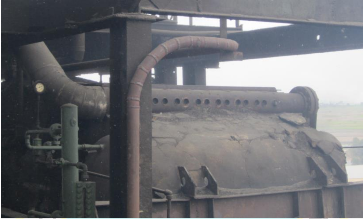
Figura 37. Domo superior del caldero 2
