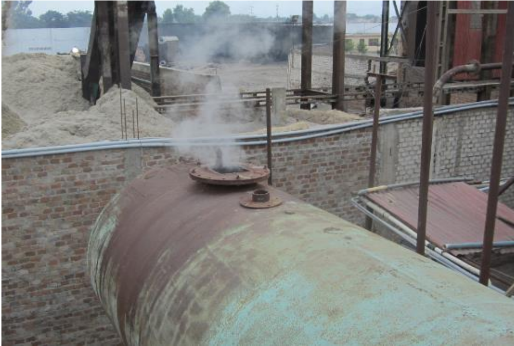
Figura 4. Perdida de energía por reevaporizado en tanque de almacenamiento 7
