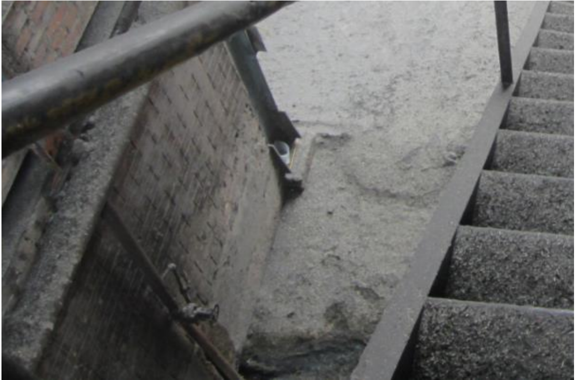
Figura 34. Purga de la caldera 1
