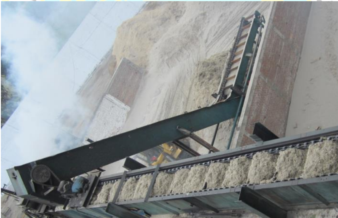
Figura 20. Conductor de bagazo principal del trapiche para su almacenamiento
