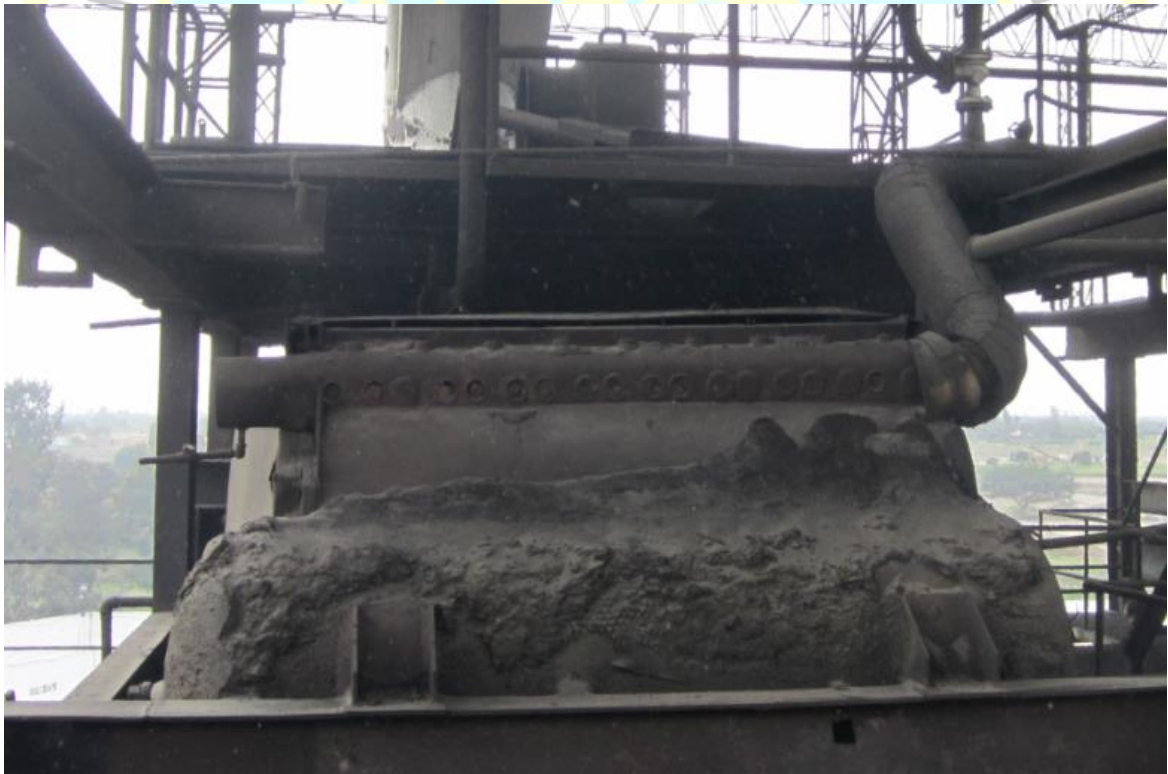
Figura 36. Domo superior del caldero 1
