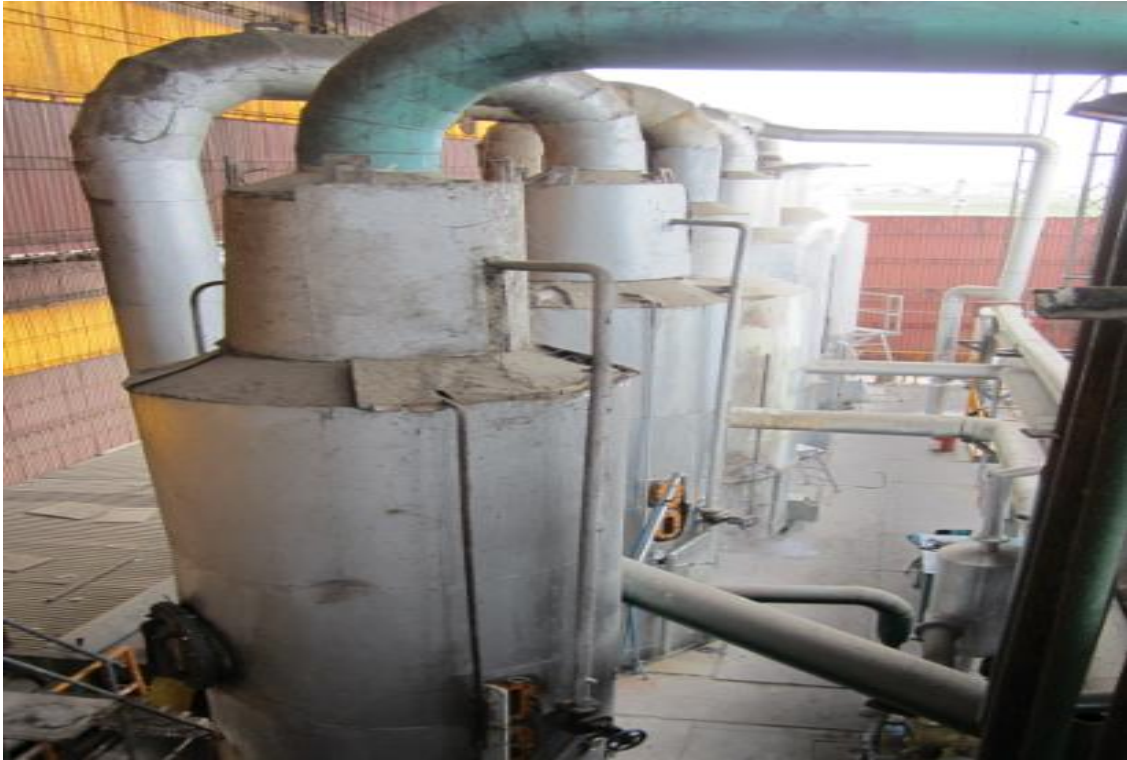
Figura 53. Evaporadores de cuádruple efecto.
