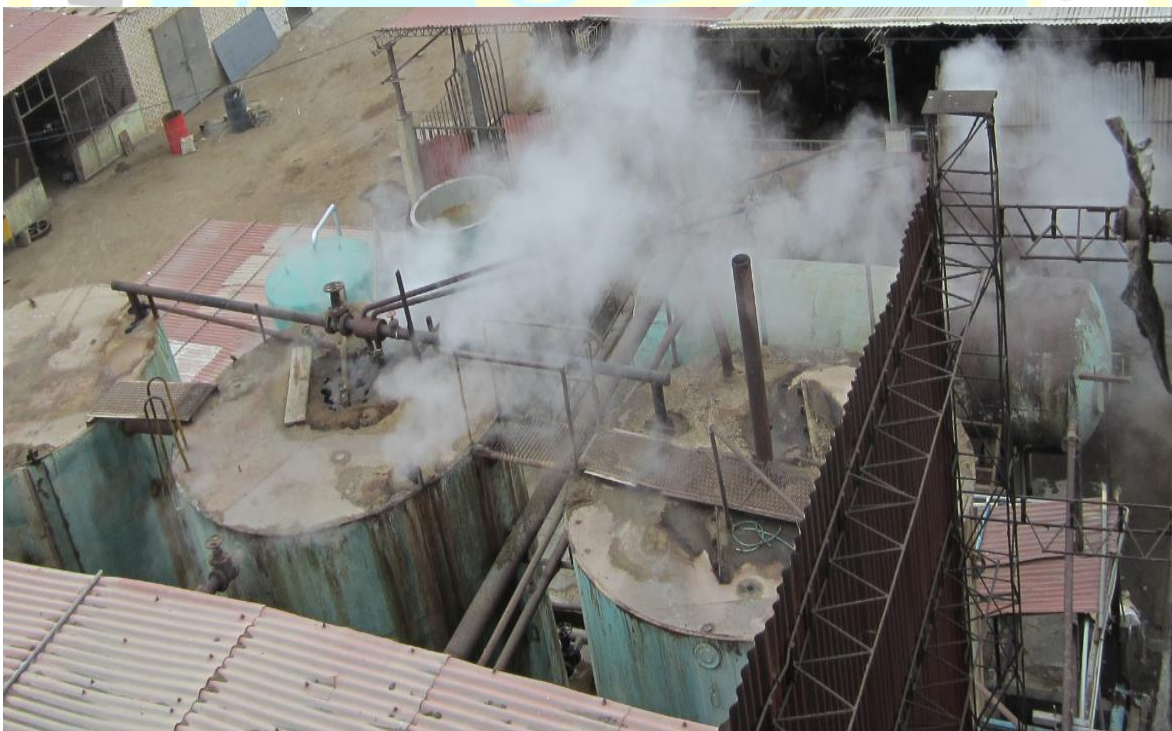
Figura 1. Vista general de las pérdidas de energía por reevaporizado en los tanques de almacenamiento 3, 4, 5, 6 y 7
