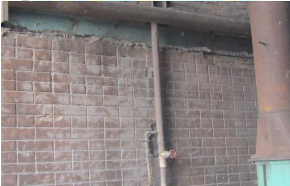
Figura 35. Purga de la caldera 2
