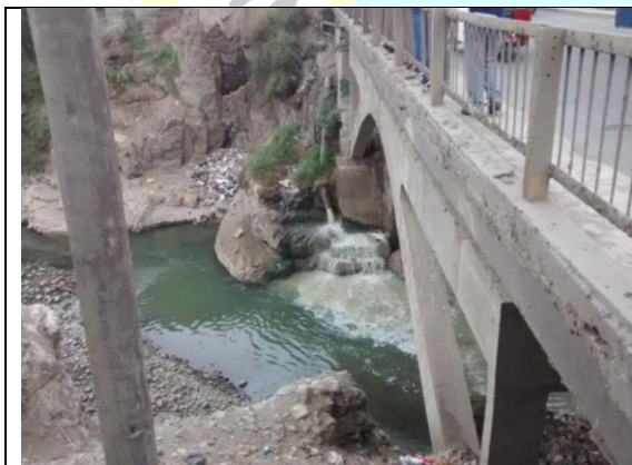
Emisor de aguas residuales municipales bajo el puente Huaura
