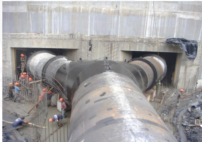
Figura 1. Tubería forzada o de presión.
