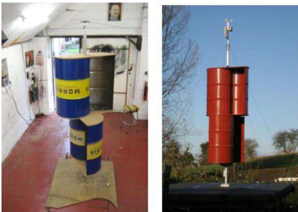
Figura 3. Construcción de un generador Savonius.
